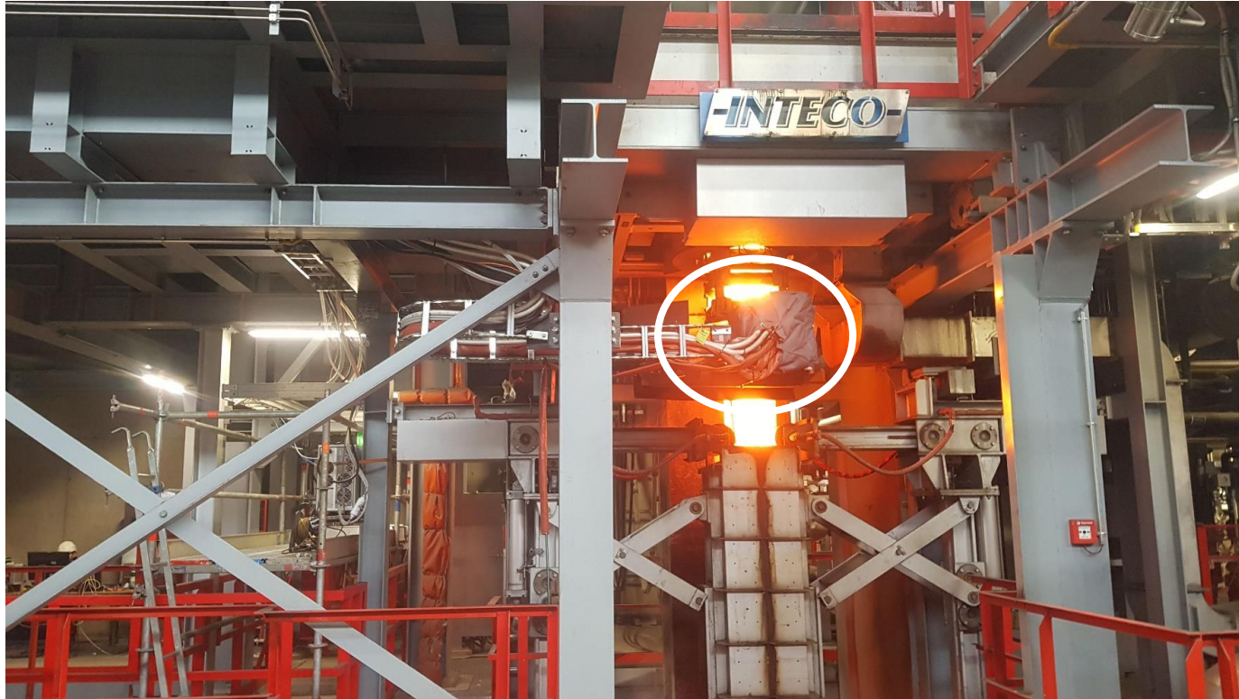
Technikum of voestalpine Stahl Donawitz
